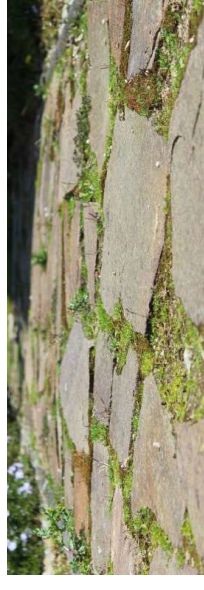
Keien en afgevlakte keien (t.b.v. toegankelijkheid)
